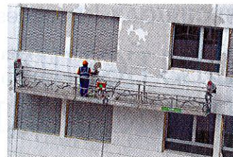
Plateforme suspendue motorisée MODULECO avec treuils e-lift 600 T.
