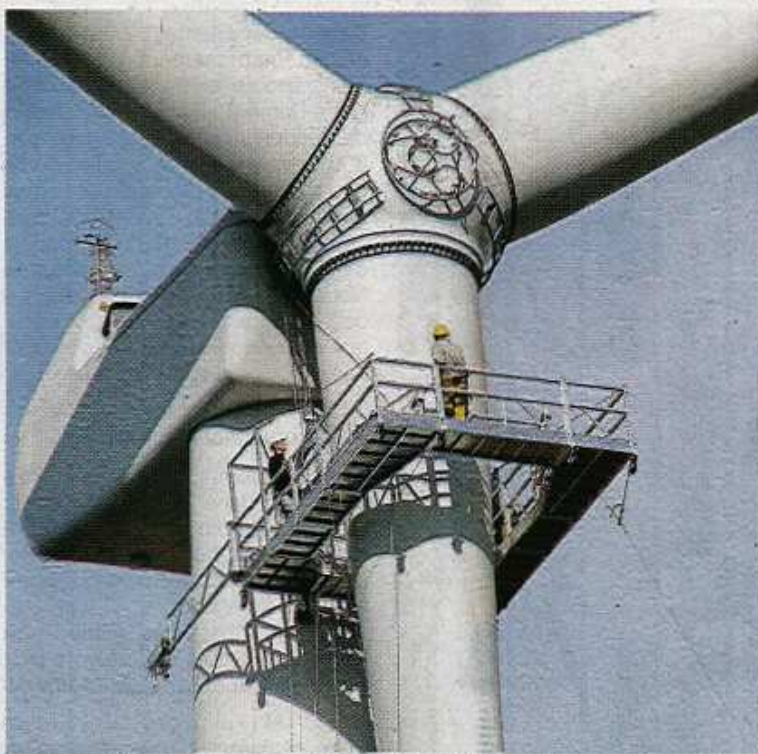
Fixator, installé dans le Maine-et-Loire, réalise déjà des plateformes suspendues utilisées par certains constructeurs d'éoliennes pour leur maintenance.
